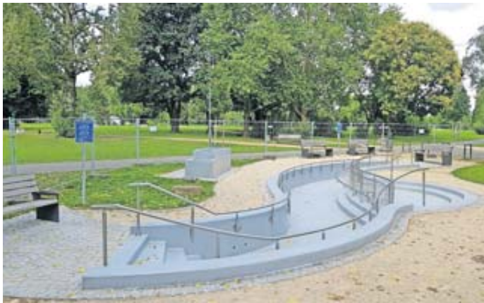
Die Kneipp Anlage wurde mit einer Beschichtung zur Rutschfestigkeit sowie besseren Reinigung ausgestattet und ist ab sofort wieder nutzbar.
