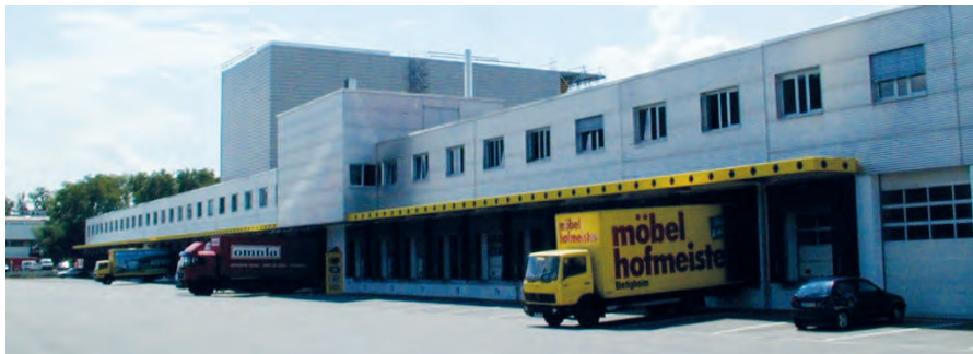
Setzte immens früh auf einen sehr hohen Automatisierungsgrad: Das 2005 gebaute Zentral- lager von Hofmeister in Bietigheim.
