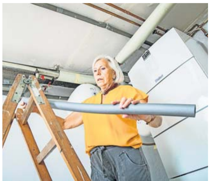
Eine effektive Dämmung schützt Rohrleitungen im Winter vor dem Zufrieren. Foto: Christin Klose/dpa-mag
