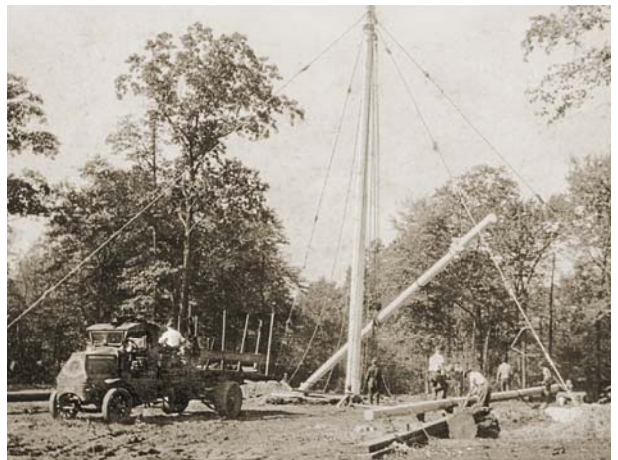
Einer der Masten für die WBBR-Antenne wird aufgerichtet
