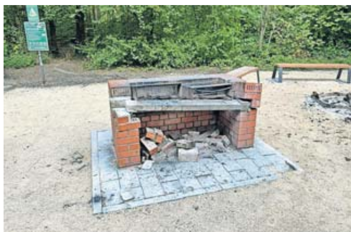
Der zerstörte Grill.
