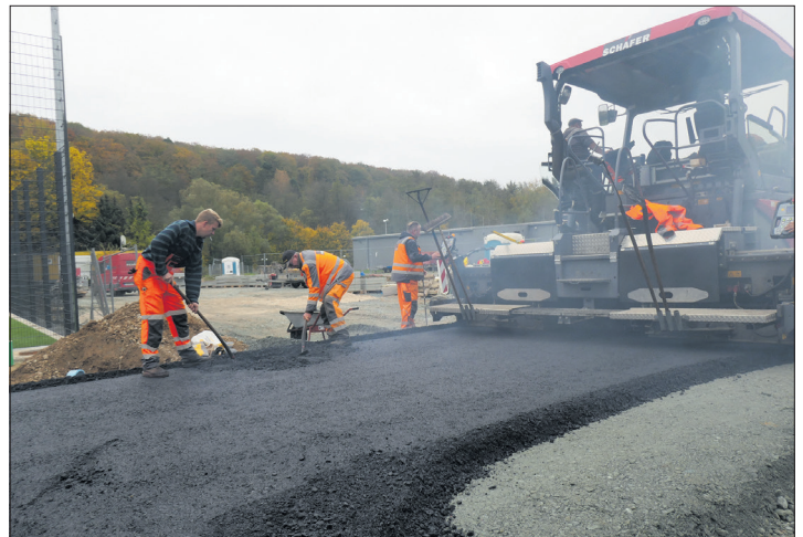
Die Baustraße für den Kindergartenbau ist inzwischen asphaltiert.
