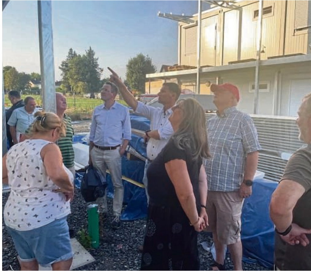
Die Mitglieder des Bauausschusses inspizieren die Baustelle: Am Flüchtlingsheim geht es nicht weiter. Eröffnet wird es wohl erst kommendes Jahr.
