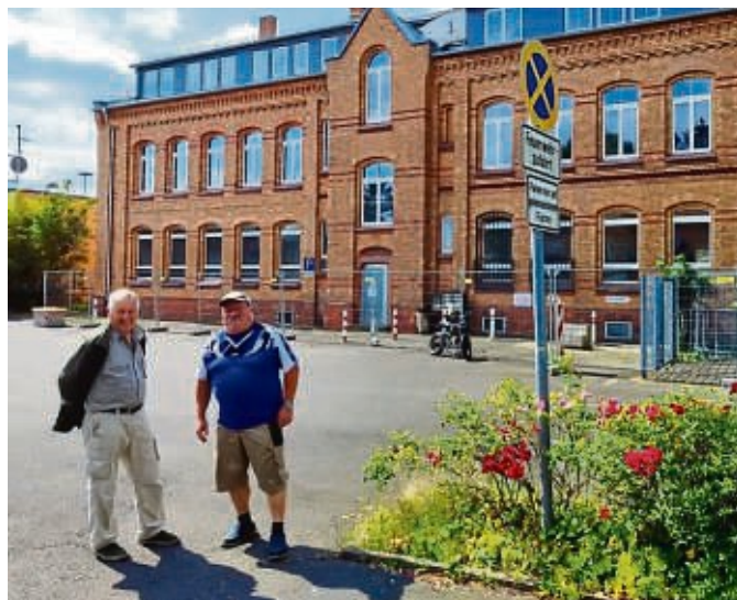
Eine Nutzung des denkmalgeschützten Gebäudes in Wolfgang ist nach jahrelangem Leerstand in Sicht. Heinz Ross und Norbert Schaffert (rechts) würde das freuen.
