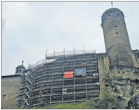
Rechtzeitig zum Start der Adventszeit wird das Außengerüst abgebaut. Foto: Stadt Eppstein
