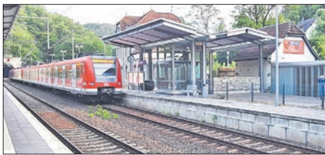
Blick von Gleis 2 zum Stadtbahnhof Eppstein.
