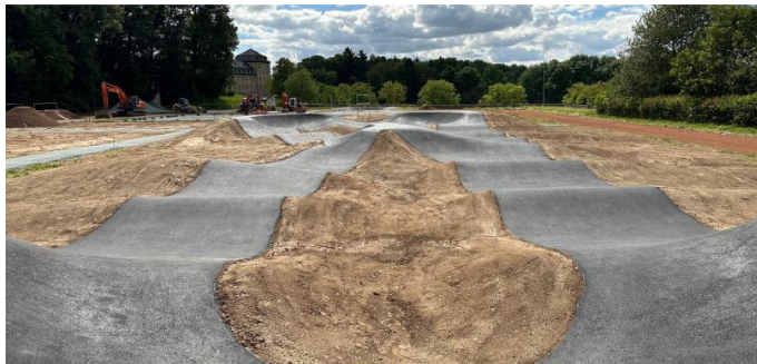
So weit sind die Arbeiten an der Pumptrack-Bahn inzwischen fortgeschritten.
