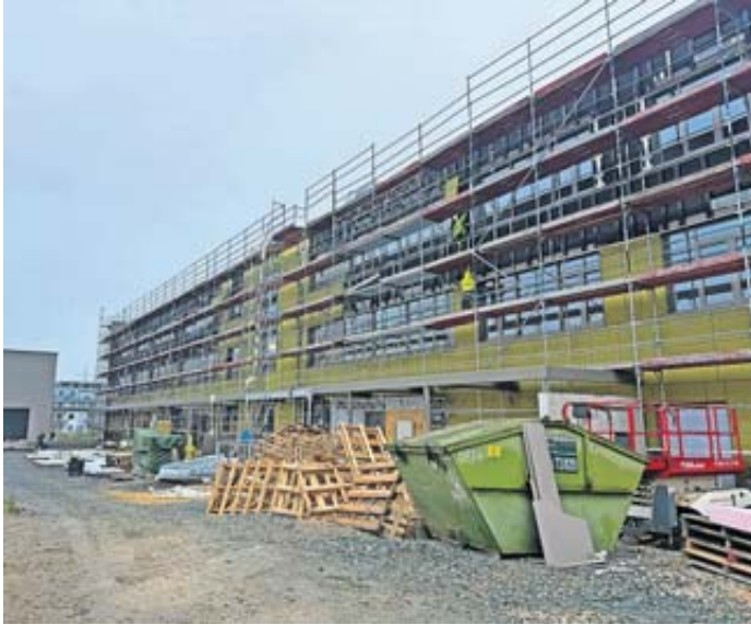
Auf der Baustelle wird intensiv daran gearbeitet, den entstandenen Zeitverzug weitestgehend aufzuholen.
