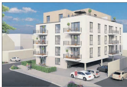
Ansicht des Bauprojektes an der Hauptstraße/Ecke Taunusstraße. Eine Beschreibung wird der EZ-Ausgabe nächste Woche beigelegt.
