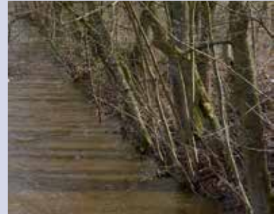
Abb. 5: Grünverrohrung durch zu eng gesetzte Bäume.
