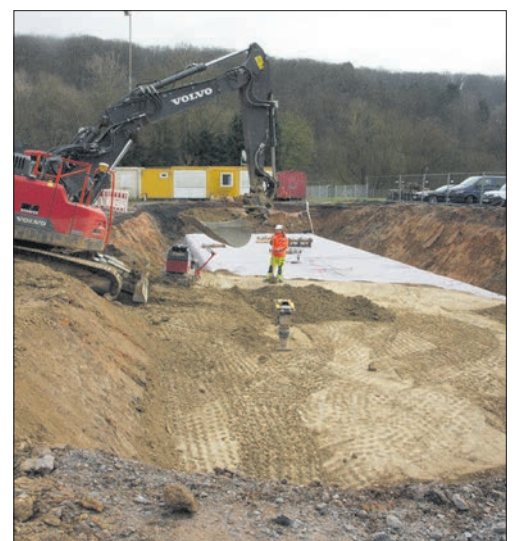
März: An der Embsmühle entsteht ein unterirdisches Regenrückhaltebecken – eine sogenannte Rigole – als wichtige Vorarbeit für den neuen Kindergarten. Foto: EZ
