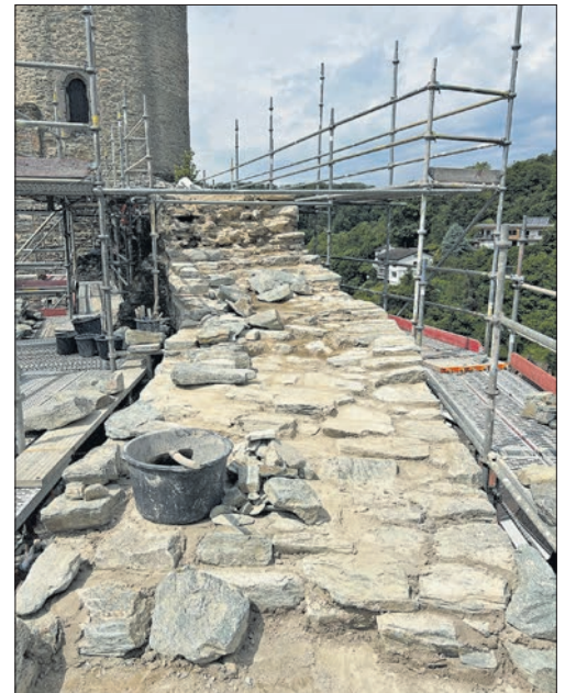
Juni: Die neue Abdeckung aus Naturstein soll verhindern, dass weiterhin Feuchtigkeit in die nördliche Schildmauer der Burg eindringt. Foto: Burgmuseum Eppstein
