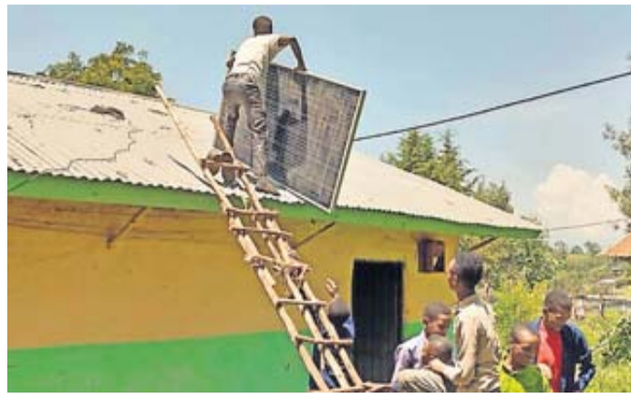
Die vom SVH organisierte PV-Modulinstallation auf dem Dach einer Schule im ländlichen Raum von Äthiopien.
