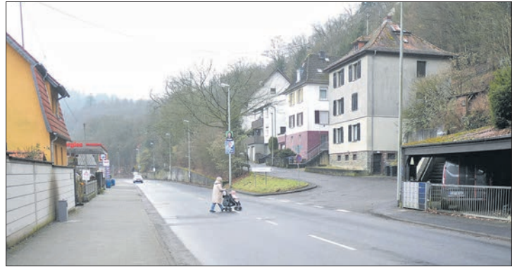
B455, Höhe Langenhainer Straße: Ein sicherer Fußgängerüberweg sieht anders aus...
