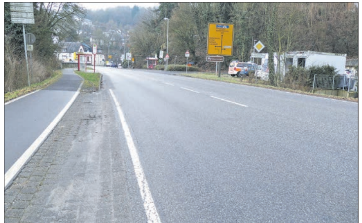
Auf der B455 noch vor der Rettungswache wird eine Querungshilfe für Radfahrer gebaut. Fotos: Beate Schuchard-Palmert
