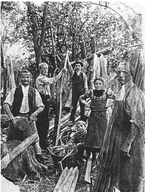
Abb. 7: Franz Orth aus Hallgarten reißt mit „Pehlbeil“ und Schlegel Weinbergspfähle aus Eichenholz bei Familie Friedrich (Joseph) in Kiedrich 1904. (Samml. Staab).
