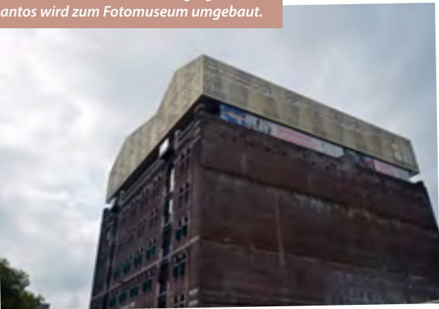
Das historische Warenlagergebäude Santos wird zum Fotomuseum umgebaut.
