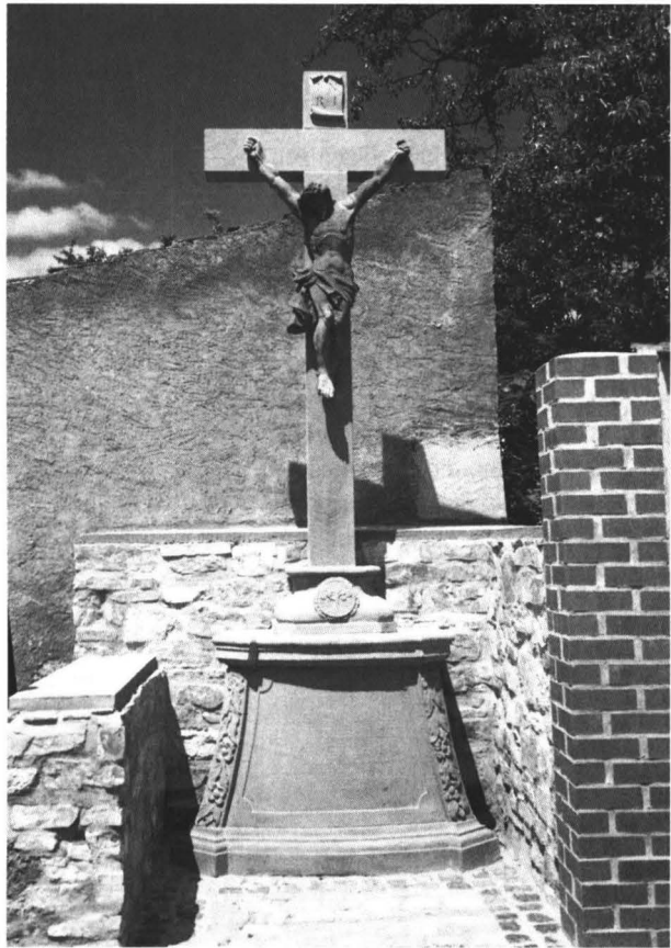
Abb. 4: Wegkreuz in Mittelheim nach der Restaurierung.
