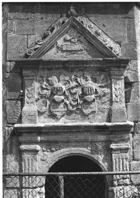
Abb. 5: Portal des Treppenturms
