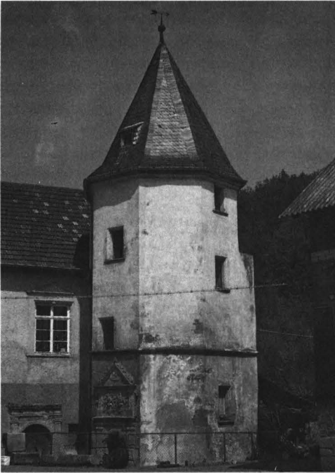
Abb. 3: Marienpforter Hof, Treppenturm von 1567
