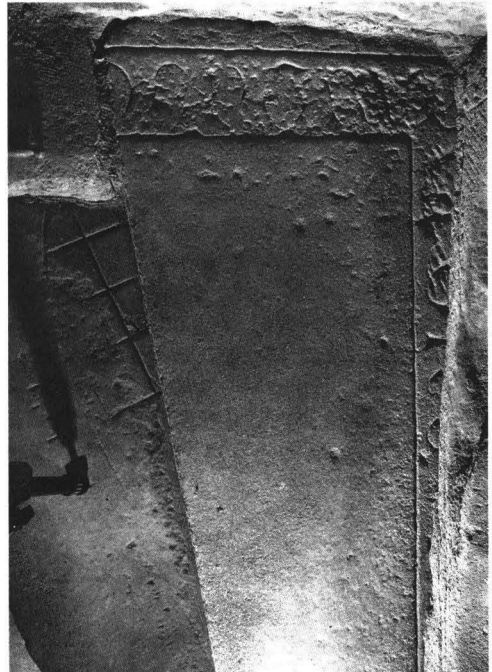
Abb. 10: Treppenturm, zur Stufe umgearbeitete Grabplatte mit Umschrift in gotischer Majuskel (14. Jh.), darunter Stufe mit Umschrift und Wappen der Familie (Wolf) von Sponheim
