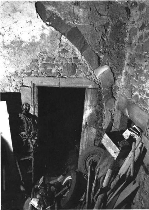
Abb. 6: Kellerseitiger Zugang zum Treppenturm mit Rundbogen
