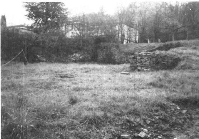
Abb. 6: Die heute noch vorhandenen Grundmauern-Reste des Hauptgebäudes, in dem bis zum Abriß die Familie Hiller und eine weitere Familie gewohnt hatten. Zu erkennen ist auch noch die Verebnung des Arbeitsbereiches im Vergleich zu dem am rechten Bildrand abfallenden Gartengelände.
