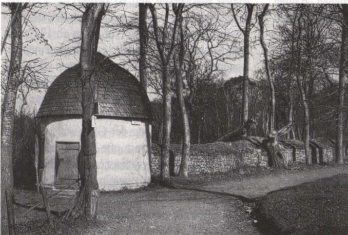
Abb. 7: Die Zauberhöhle: Gemauerter Gang und Rotunde (Zauberhütte). Foto von ca. 1939; heute fast unverändert.
