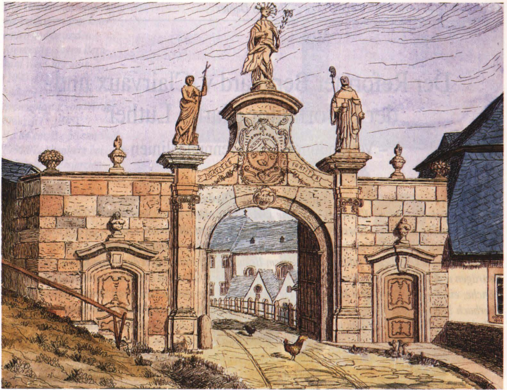
Abb. 16: KLOSTER EBERBACH: Portal am Zugangsweg.
