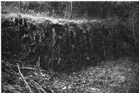
Abb. 4: Restliche Weinbergsmauer in Presberg mit interessanter Mauertechnik (hochkant gestellte Schieferplatten). Aufnahmen: P. Claus
