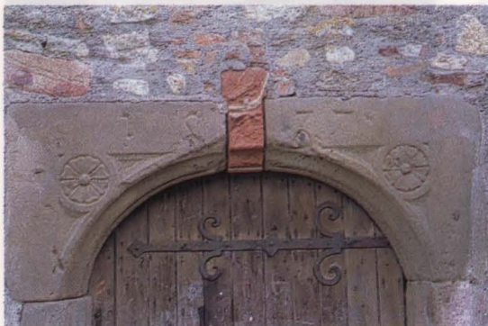
Renaissance-Türgewände als Zugang zu einem ebenerdigen Gewölberaum unter der Aussichtsterrasse in der Südostecke der Gartenterrasse.
