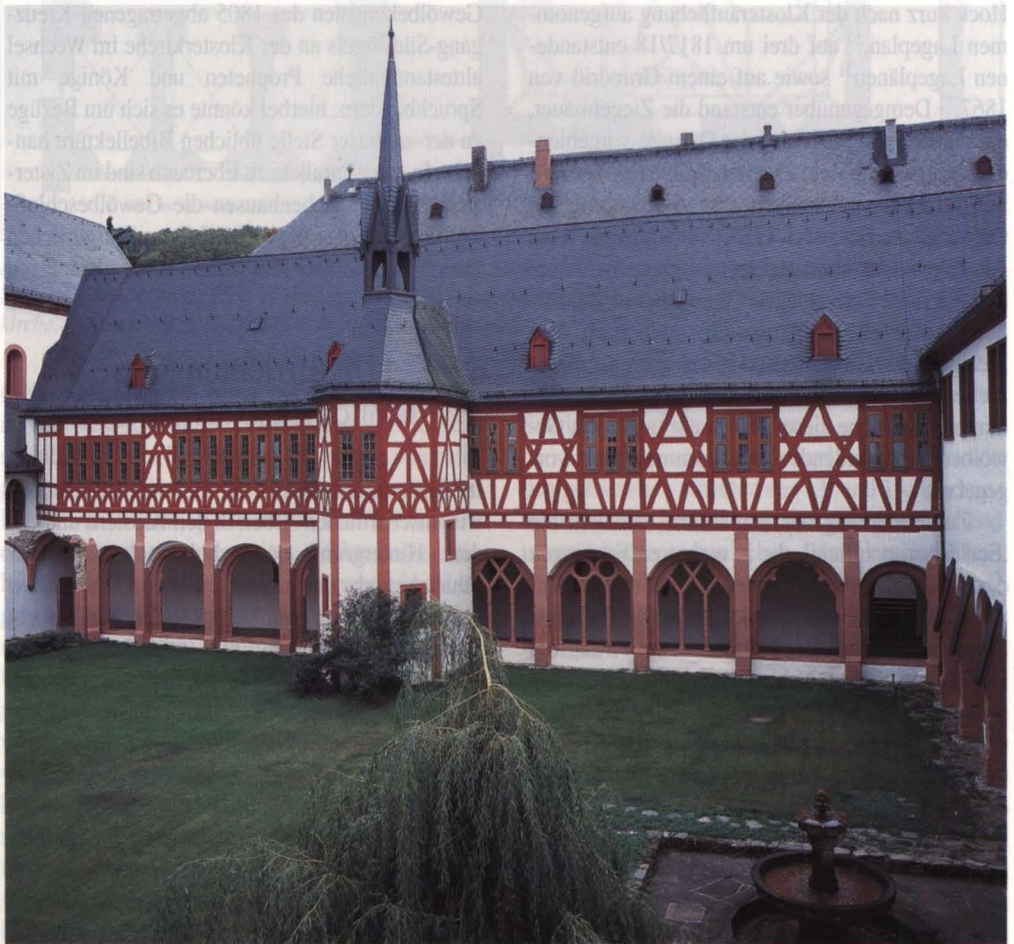
Abb. 3: Kloster Eberbach, Bibliotheksbau. Ansicht von Osten mit der rekonstruierten spätgotischen Befensterung (Aufnahme 1998). Foto: Karl-Heinz Seidl, Walluf.
