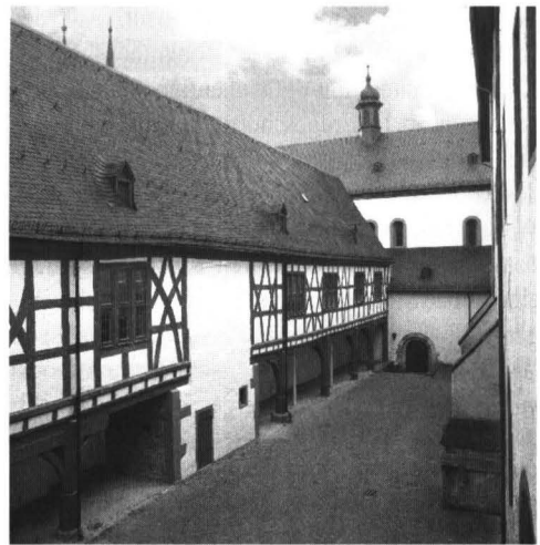
Abb. 4: Kloster Eberbach. Westfassade des Bibliotheksbaus. Ansicht von Norden mit Konversengasse und Klosterkirche (Aufnahme 1998). Foto: Karl-Heinz Seidl, Walluf.
