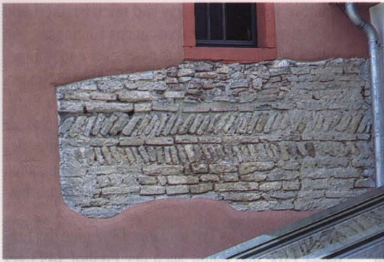
Freigelegtes römisches Mauerwerk (opus spicatum) in der Nordwand des Westbaus.
