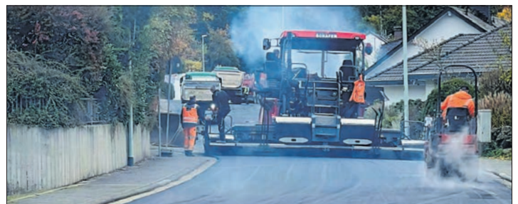
Deckensanierung in Eppstein: Die Stadt hatte einen Zwei-Jahres-Auftrag vergeben und bereits 2024 mehrere Straßendecken sanieren lassen. Das Foto zeigt die Arbeiten in einem Teilabschnitt der Bergstraße.
