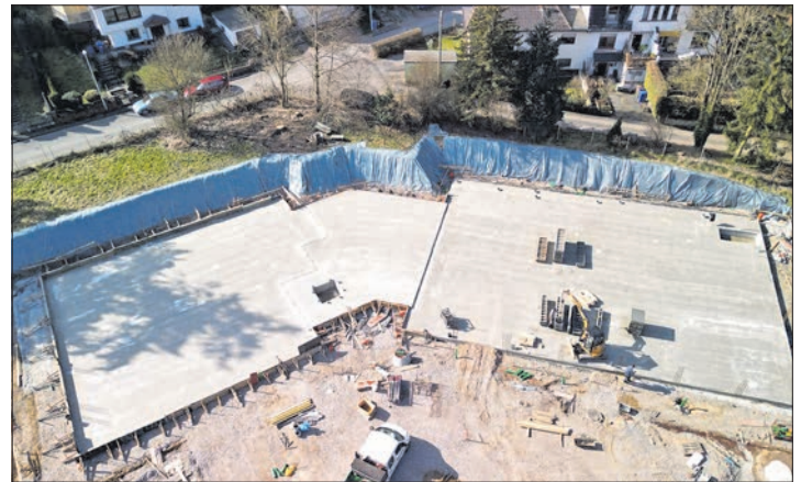
Die Bodenplatte für den neuen Kindergarten mit der Drohne aus der Luft fotografiert. Foto: Jochen Haupt
