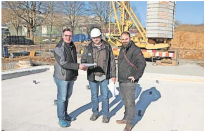
Sie freuen sich über den guten Vorgang der Arbeiten im Freibad Schlüchtern (von links): Mario Zirkel von der Stadtentwicklungsgesellschaft, Ralph Klein von der Firma Philipp sowie Daniel Storbeck vom Planungsbüro IWTI stehen im künftigen Nichtschwimmerbecken. Foto: Stadt Schlüchtern
