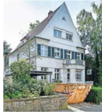
Es muss nicht immer die allumfassende Sanierung sein. Auch kleine Maßnahmen können die Attraktivität einer Immobilie steigern. Foto: Kirsten Neumann/dpa-mag
