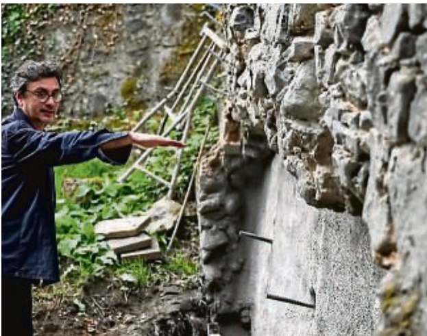
Stahlstreben stabilisieren die Mauer: Architekt Joachim Backes erläutert die Sanierungsmaßnahmen.
