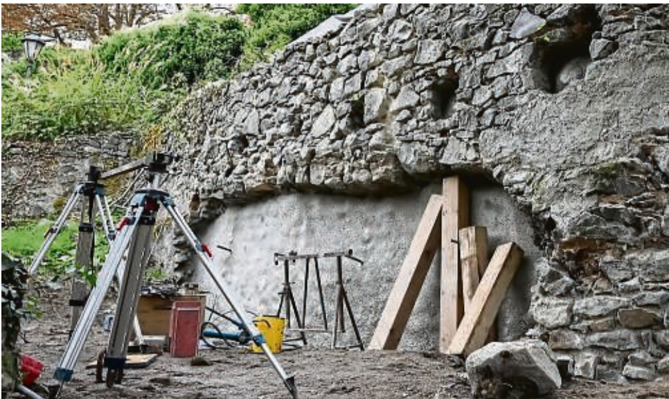
Die Mauersohle wird mit Spritzbeton unterbaut, bevor die Bruchsteine eingesetzt werden und die historische Optik wiederhergestellt wird. Bis Ende November soll die Sanierung abgeschlossen sein.
