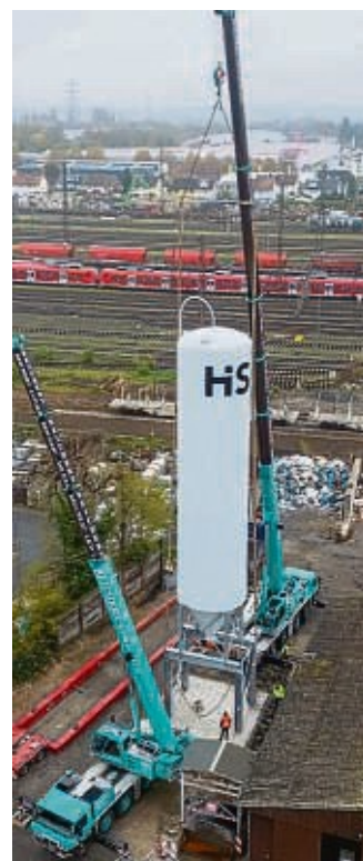
Das neue Silo ist aus Kunststoff und verzinktem Stahl gefertigt und laut der Stadt äußerst robust. FOTO: PM
