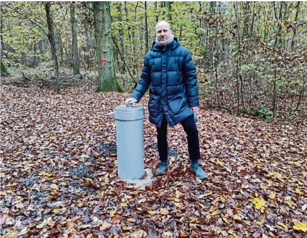
Stadtwerke-Bereichsleiter Dr. Dirk Drescher an einem der neuen Brunnen. FOTO: SEIFERT
