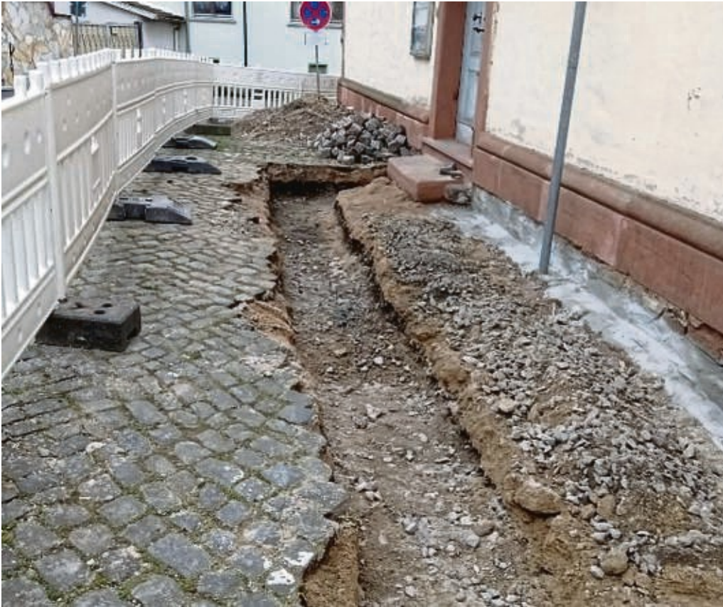
Die evangelische Kirche in Kilianstädten bekommt einen barrierefreien Zugang.
