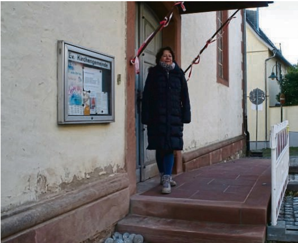
Susanne Lackenbauer vom Förderverein der evangelischen Kirchengemeinde Kilianstädten/Oberdorfelden am Kirchenportal in Kilianstädten. Hier ist mit Mitteln des Vereins eine neue Rampe gebaut worden. Jetzt fehlt nur noch das Geländer. Die Weihnachtsgottesdienste können so barrierefrei erreicht werden.
