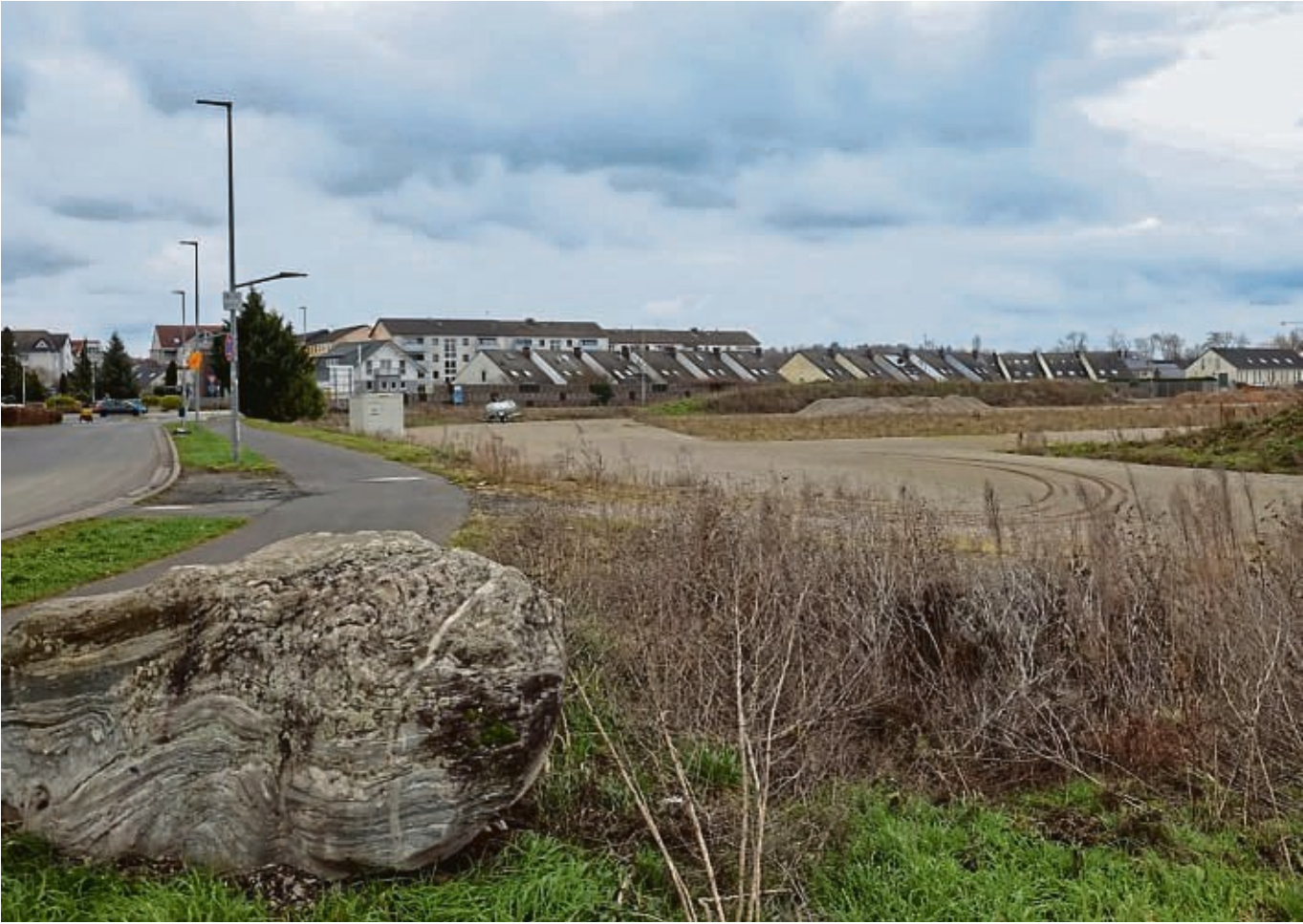
Der Bauzaun um das Areal, auf dem das Gesundheitscenter entstehen soll, ist abgebaut worden. Wie es um den insolventen Investor Schoofs steht und ob das Projekt noch verwirklicht wird, ist nach wie vor offen.
