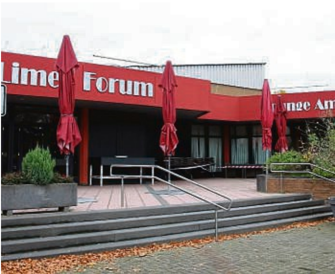
Endlich kein Wasser mehr von oben: Das Dach des Bürgerhauses ist fast komplett saniert.
