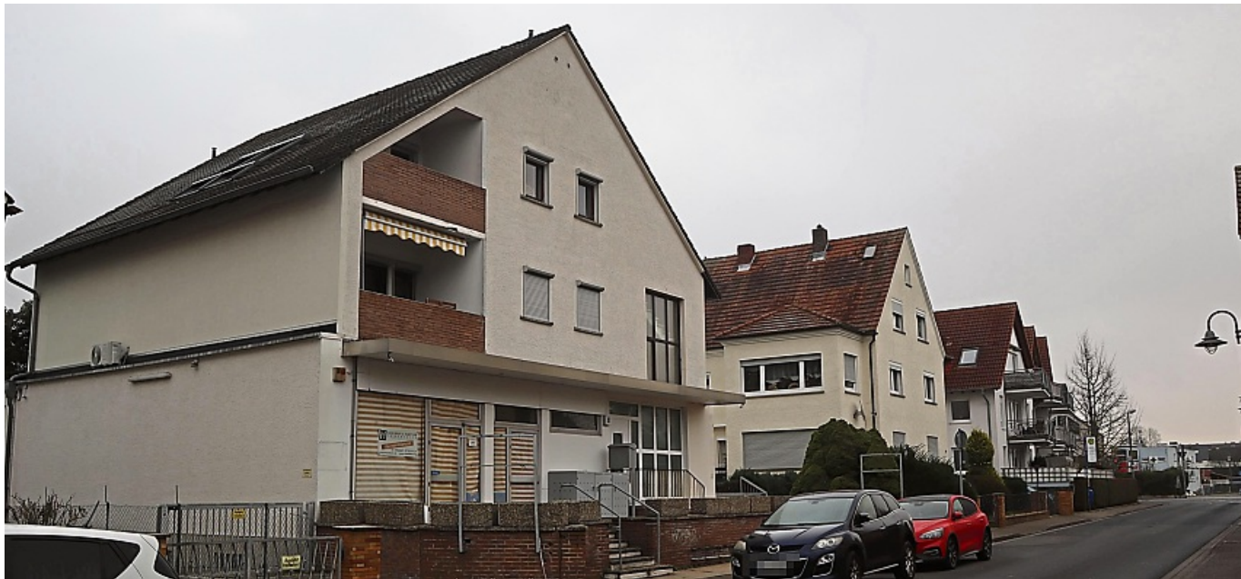
Neues Domizil für Tafel, Textilshop, Kinderladen und Co.: In der ehemaligen Schlecker-Filiale in Alt Bischofsheim soll die neue Heimat der Bürgerhilfe entstehen.
