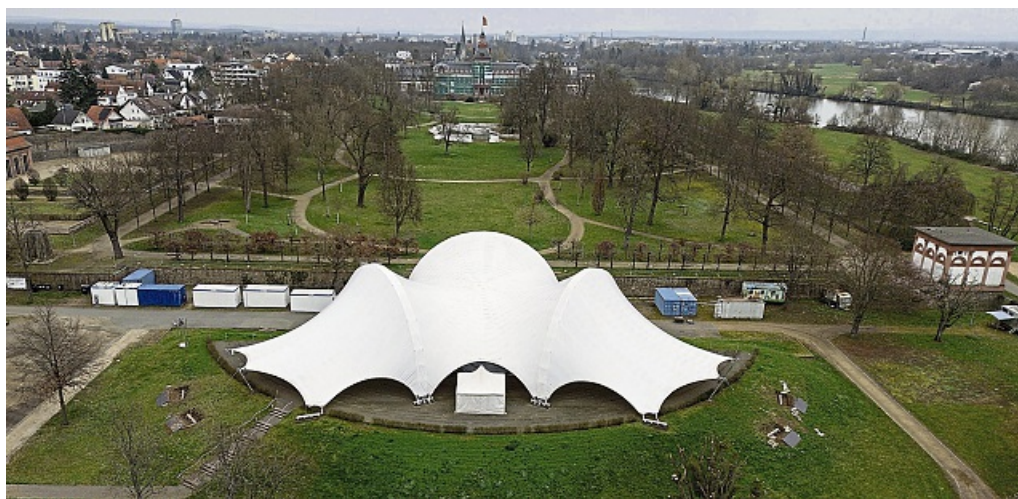
Das Zeltdach über dem Amphitheater ist schon gespannt.
