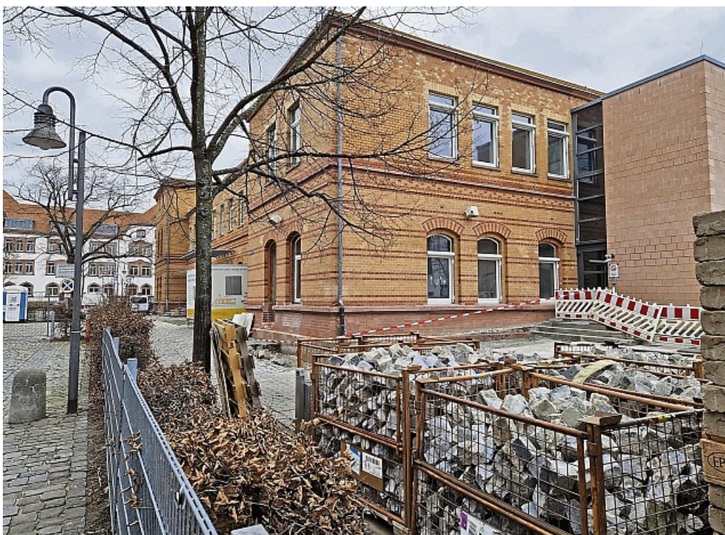
Im alten Gebäude der Tümpelgartenschule am Ulanenplatz entsteht die neue integrative Kita des Behindertenwerks.
