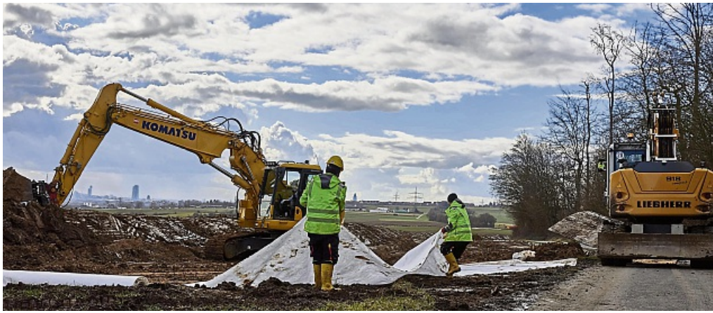
Die Hohe Straße ist zwischen Bischofsheim und Niederdorfelden gesperrt , weil eine Hochspannungsstromleitung gebaut wird, die ein neues Rechenzentrum in Fechenheim mit dem Umspannwerk Karben verbinden soll.
