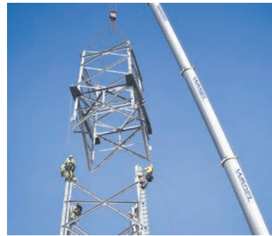
Montage einer Masterrhöhung für eine Gleichstromtrasse.
