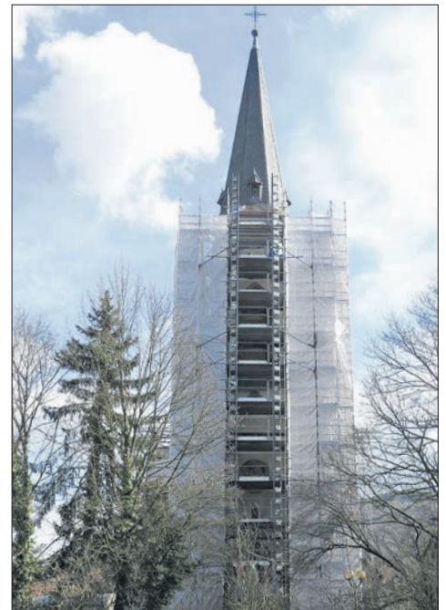
Seit Monaten ist der Kirchturm von St., Laurentius eingerüstet. Foto: bpa
