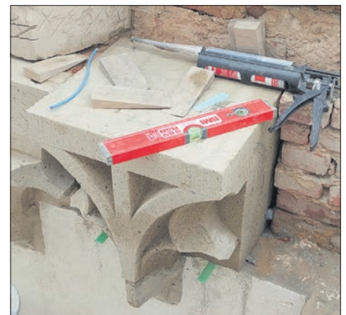
Ein neues Werkstück aus Tuffstein wird am St.-Laurentius-Turm eingesetzt. Foto: privat
