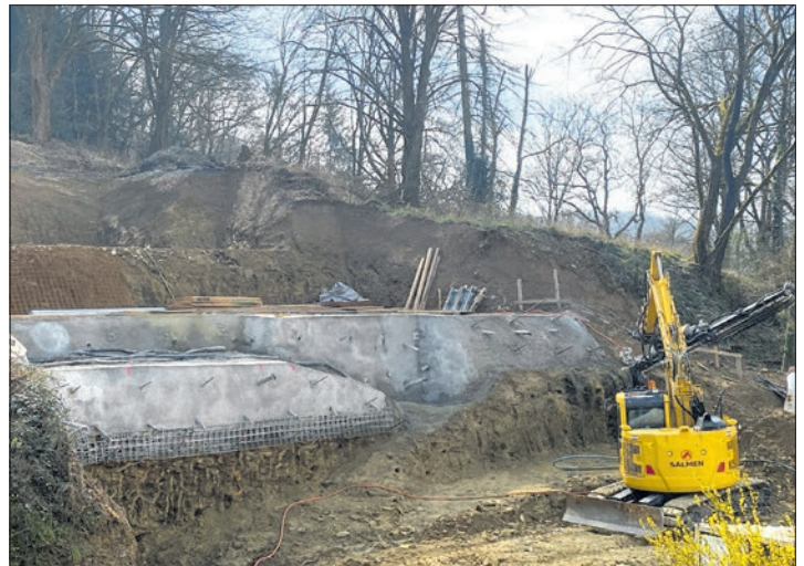
Wo in den vergangenen Jahrzehnten ein kleiner Wald heranwuchs, haben die Bagger eine tiefe Schneise in den Hang gegraben. Foto: privat
