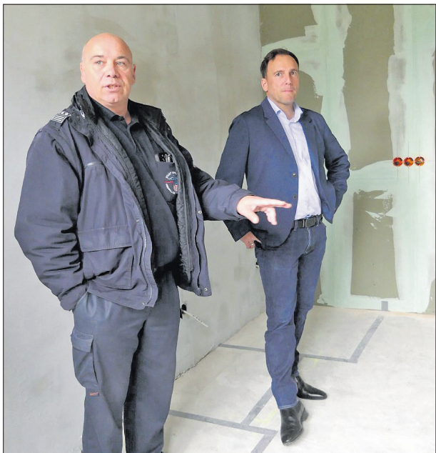
Stadtbrandinspektor Mario Mezga und Bürgermeister Alexander Simon besichtigen die Baustelle.
