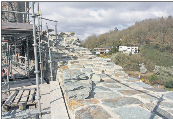
Die Mauerkrone der hohen Mantelmauer bekommt gerade ihr endgültiges Profil – mit künstlichem Versatz, um den Eindruck einer Abbruchkante zu erhalten. Foto: Beate Schuchard-Palmert
