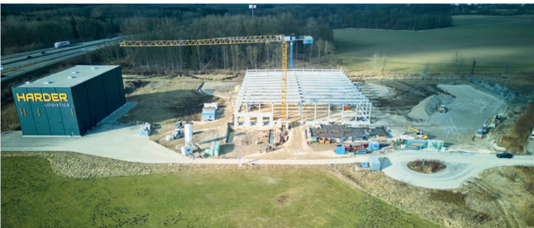
Blick auf die Baustelle: Im Oktober soll Harders neuer Firmensitz bezugsfertig sein.
