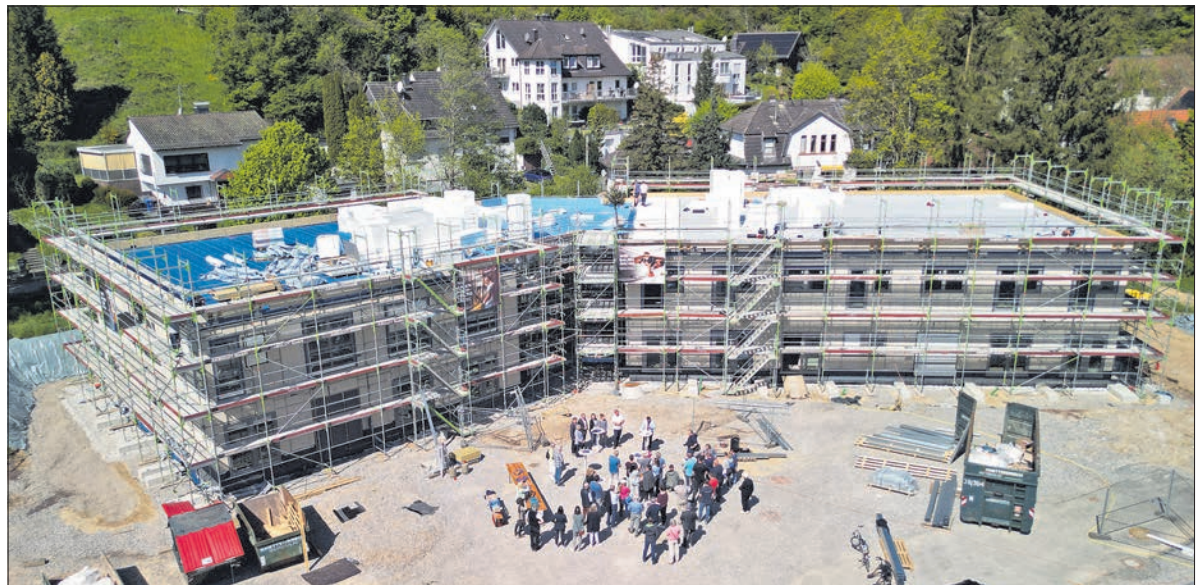
Der Rohbau steht. Jetzt wurde Richtfest in der neuen Kindertagesstätte an der Embsmühle gefeiert. Foto: Jochen Haupt
