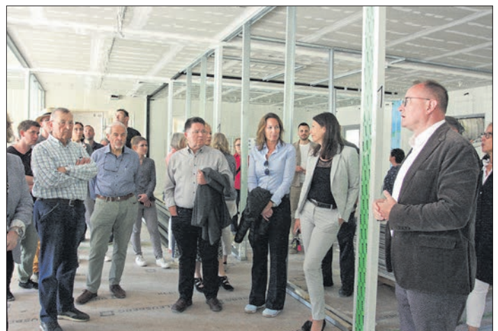
Beim Richtfest war die Besichtigung der Rohbaus auch von innen möglich. Oliver Wirfs erklärt, wo die Besucher sich gerade befinden.
