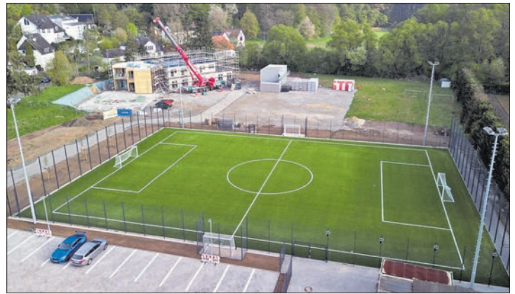
Der neue Multifunktionsplatz und im Hintergrund die Kita-Baustelle an der Embsmühle aus der Vogelperspektive. Drohnenvideo: Jochen Haupt
