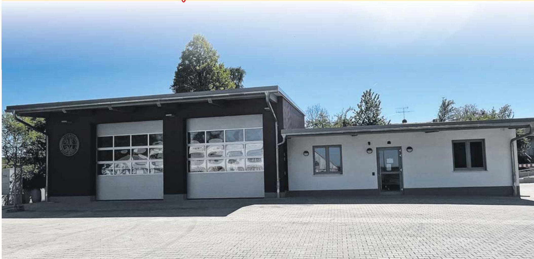
Am Sonntag, 4. Mai, wird die neue Heimat der Freiwilligen Feuerwehr Sarrod-Rebsdorf-Rabenstein endlich den Kameradinnen und Kameraden übergeben.
