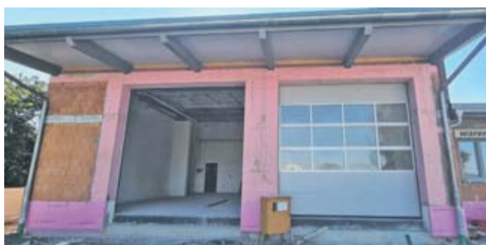
2022 wurde mit dem Bau des neuen Feuerwehrhauses begonnen. Nach etwas mehr als zwei Jahren Bauzeit ist es nun endlich fertig.
