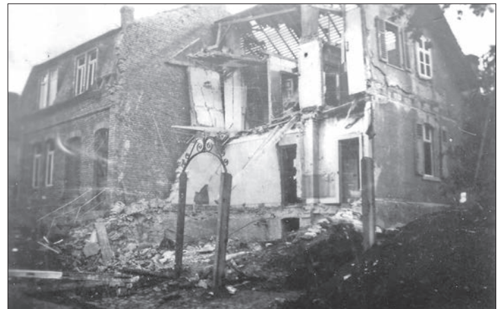
Bombentreffer in Vockenhausen im September 1944. Bremthal und Niederjosbach erlebten die schlimmste Bombennacht im Februar 1945. Etliche Häuser wurden zerstört. Foto: Privatarhiv Jakob Menke
