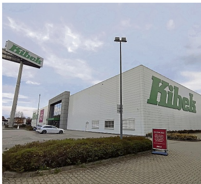
Das Kibek-Haus an der Oderstraße war Monate renovierungsbedingt geschlossen. Nun kann nach Neueröffnung ein neues, modernes Einkaufserlebnis präsentiert werden. THOMAS SEIFERT
