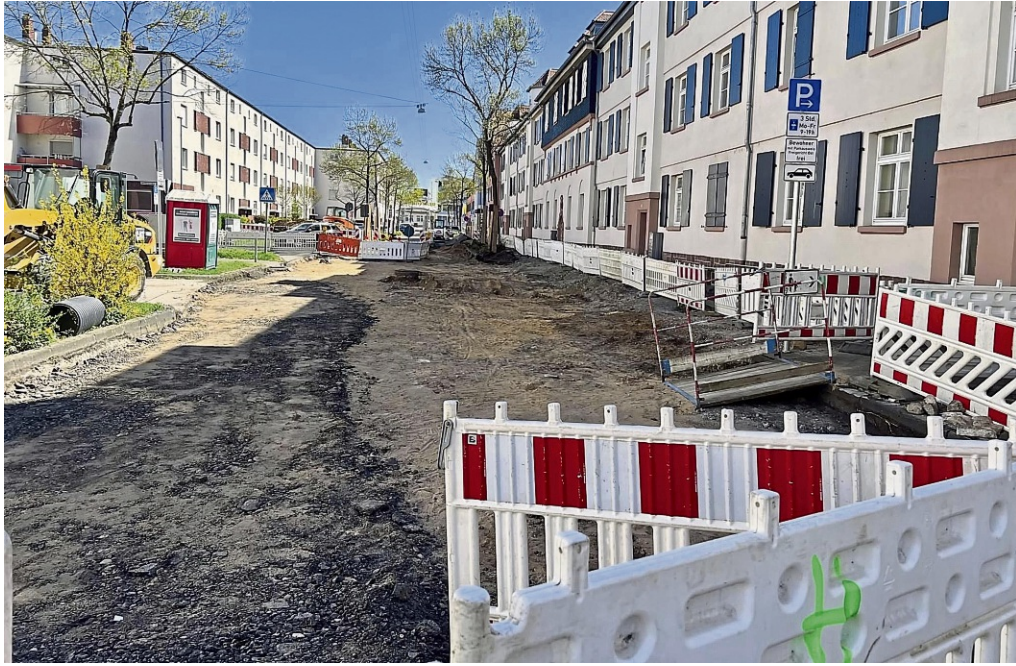
Das Freigerichtviertel soll einen neuen Treffpunkt bekommen. Daher finden zurzeit Bauarbeiten in der Freigerichtsstraße statt. PM
