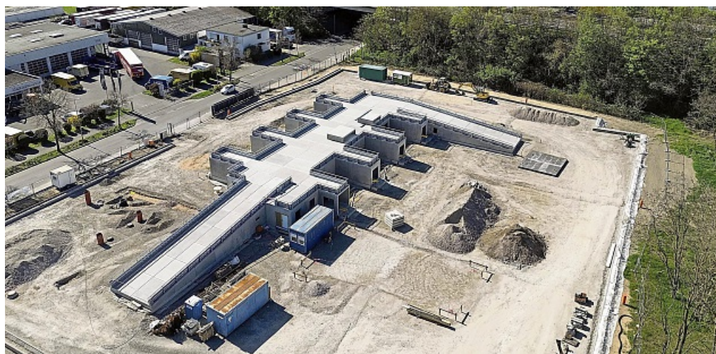
Rund sieben Millionen Euro investiert die Stadt in den neuen Wertstoffhof an der Benzstraße. Die Nutzer fahren die Container über eine Hochetage an. PATRICK SCHEIBER
