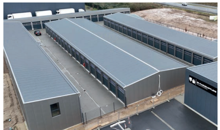
Nummer eins steht seit Januar: Der Garagenpark Alzenau ist frisch fertiggestellt.
