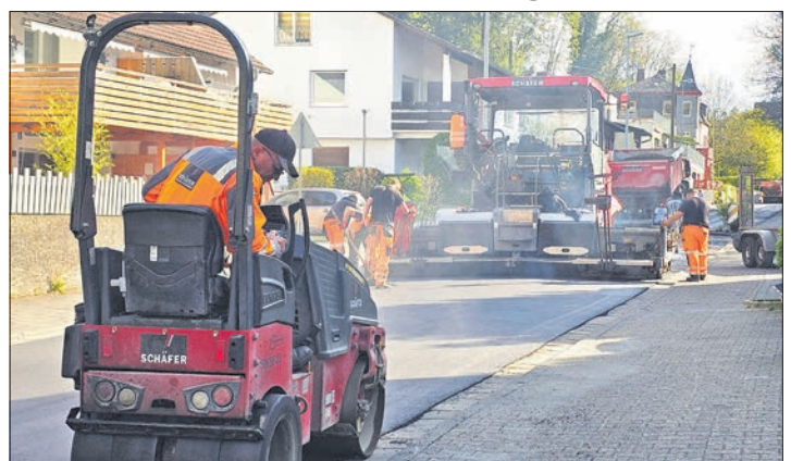
Während der Osterferien wurde die Straßenoberfläche in der Rossertstraße saniert. Foto: Stadt Eppstein
