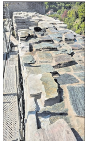
Abschluss der Mauerkrone der Nordwand von Burg Eppstein.
