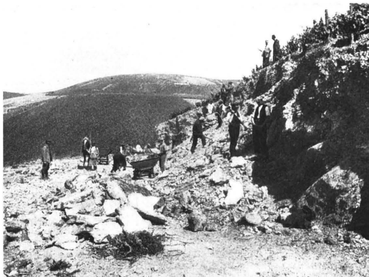
Erdbewegungen zur Verbesserung und einheitlichen Gestaltung der Lage in der Neuanlage „Taubenberg“, aus: Die staatlichen Domänenweingüter im Rheingau (nach 1928) S. 15
