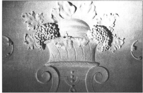
... und nach der Restaurierung
